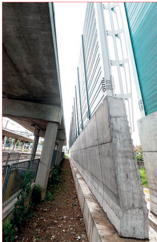
Fig. 4 - Dettaglio del manufatto, nel quale è ben riconoscibile la separazione fra cordolo di fondazione e basamento
