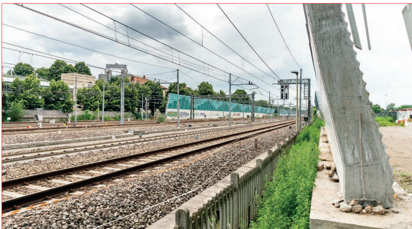
Fig. 6 - In sede di progetto esecutivo sono state operate varianti anche nella quota della barriera rispetto al piano del ferro
