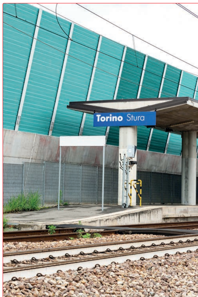
Fig. 1 - Le nuove barriere antirumore poste in opera nei pressi della stazione suburbana di Torino Stura (Foto cortesia D'Adiutorio Appalti e Costruzioni S.r.l.)
