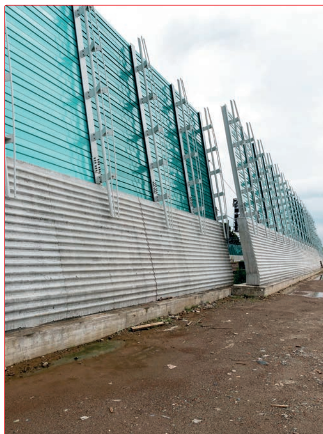
Fig. 7 - L'installazione delle nuove barriere ha comportato anche la regolarizzazione e sistemazione delle quote del terreno delle aree adiacenti
